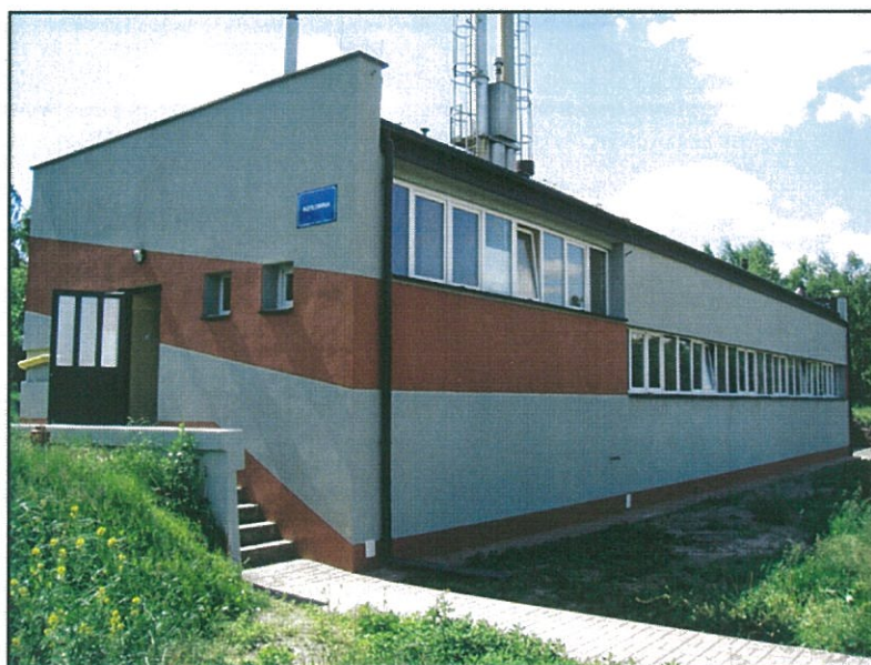
Zdj.6 Widok budynku kotłowni biogazu.
