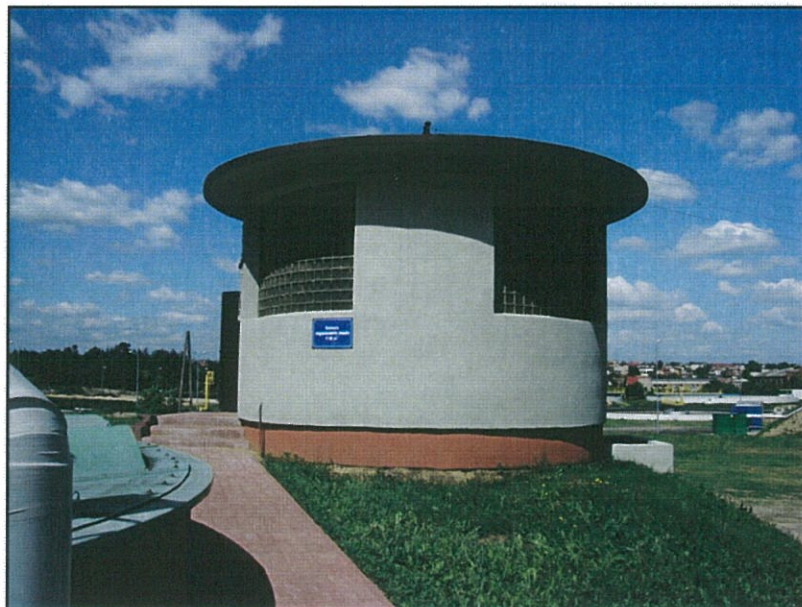
Zdj.2 Widok komory zagęszczania osadu.
