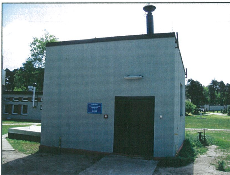
Zdj. 1 Widok budynku pompowni osadu wstępnego.
