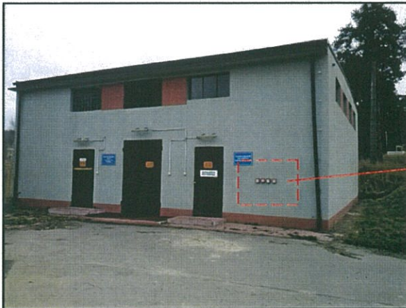
9, 10. Widok przeciwpożarowych wyłączników prądu zlokalizowanych na zewnętrznej ścianie budynku rozdzielni.
